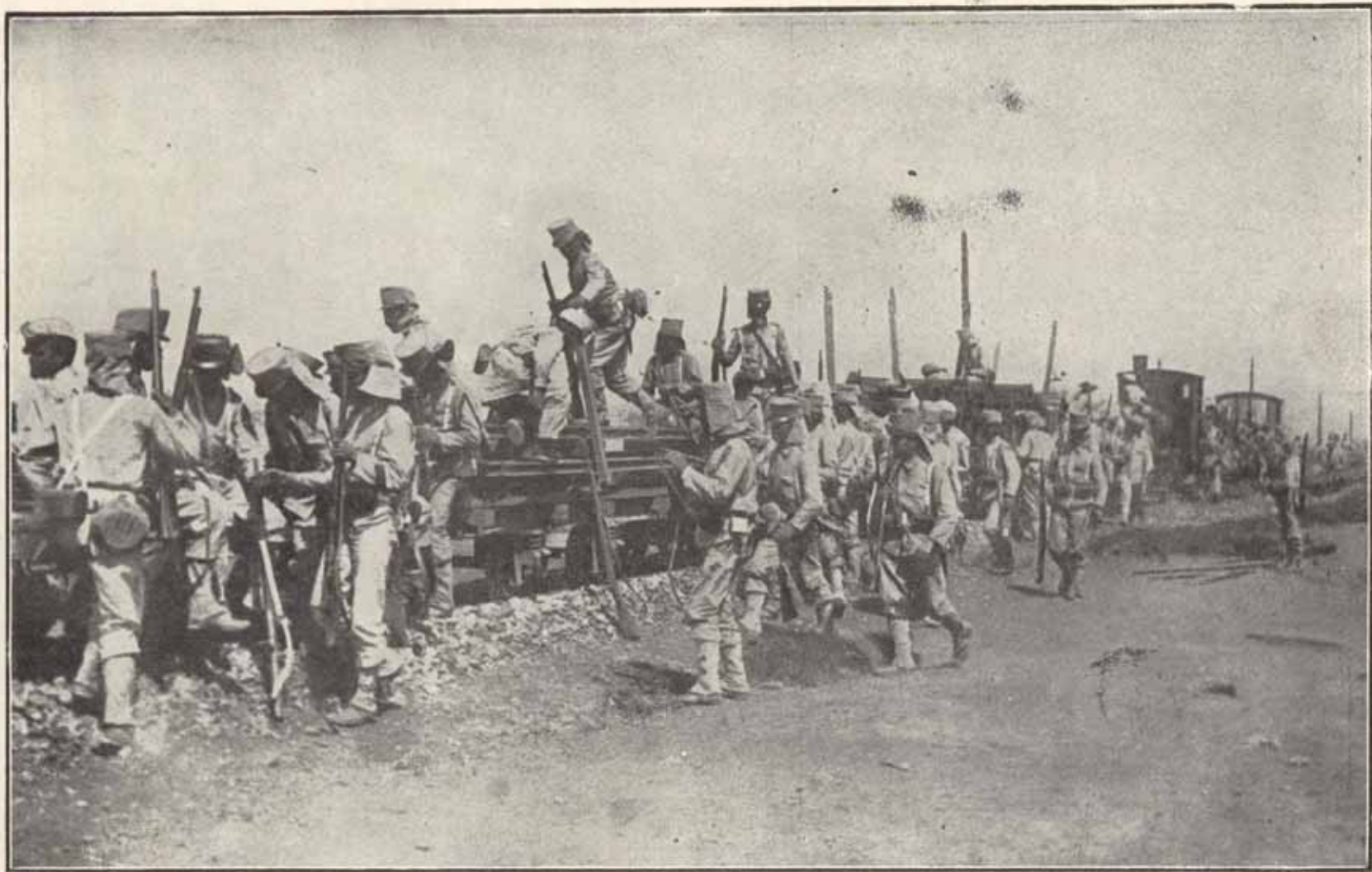
SOLDADOS DE INGENIEROS OCUPANDO LAS VAGONETAS DEL FERROCARRIL MINERO QUE CONDUCE A LOS PUNTOS AVANZADOS
